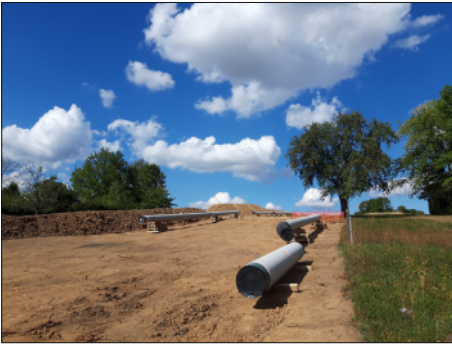
Bild 6: Bau der Neckarenztalleitung (2022) Foto: Birger Meierjohann
